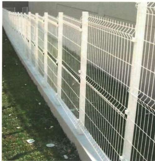
Como sustentação das muretas, prevê-se viga baldrame, com face superior acabando no nível do terreno, com dimensões da seção transversal de 0,30 x 0,20 m.
