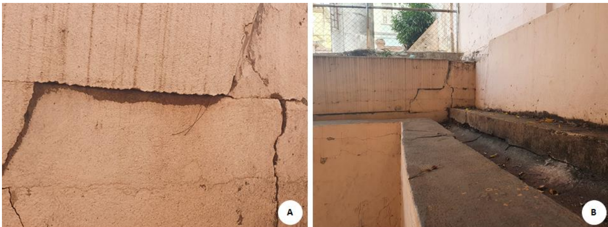
Figura 3: A-B. Rachaduras localizadas na parte interna do muro da Escola Major Prado.
