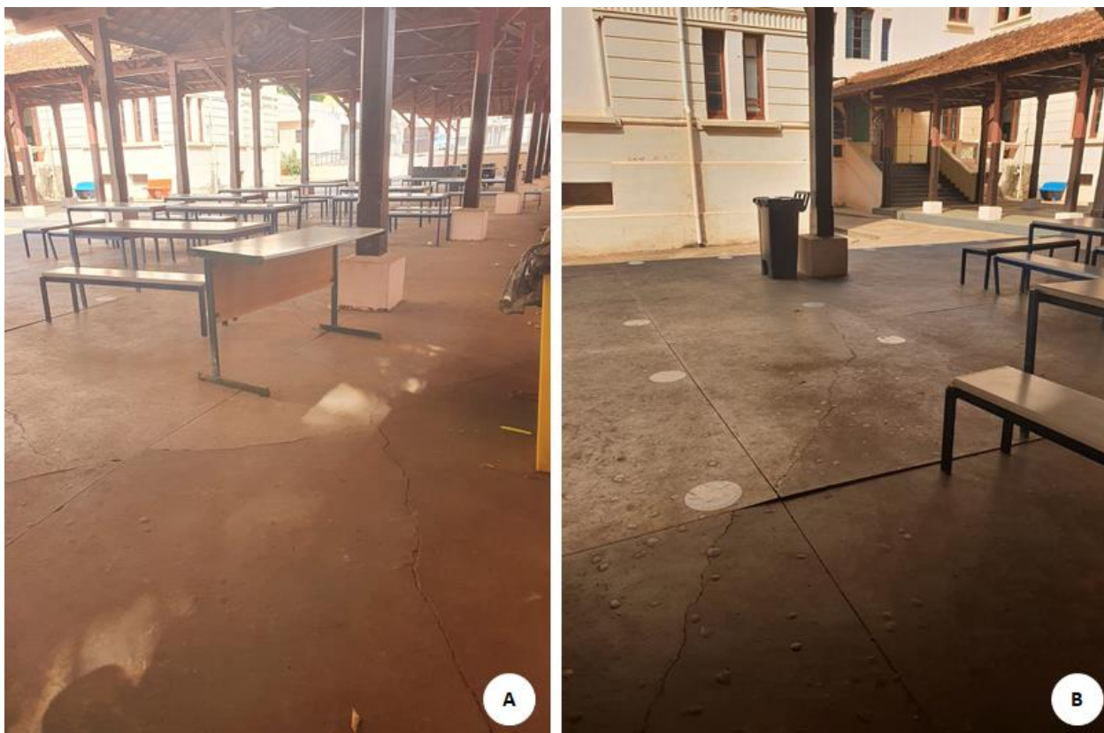
Figura 5: A-B. Piso tipo cimentado em processo de levantar em frente a Cantina da escola.
